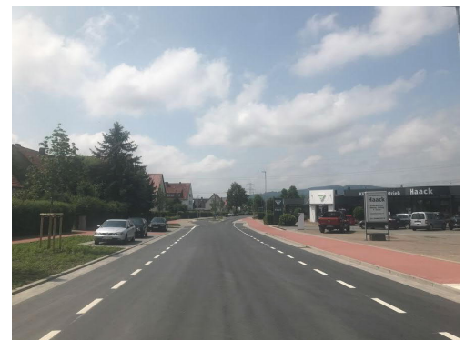
EL: Elze – Schmiedetorstraße Radschutzstreifen
