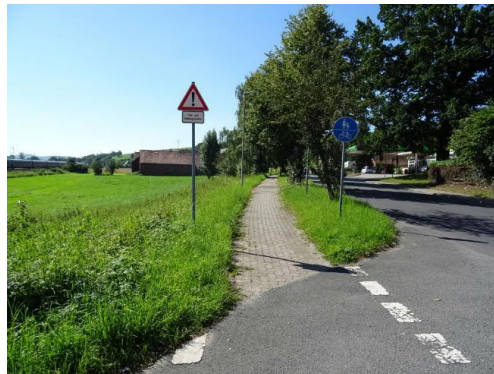
AL: Dehnsen – An der Bundesstr. gemeinsamer Geh-/Radweg
