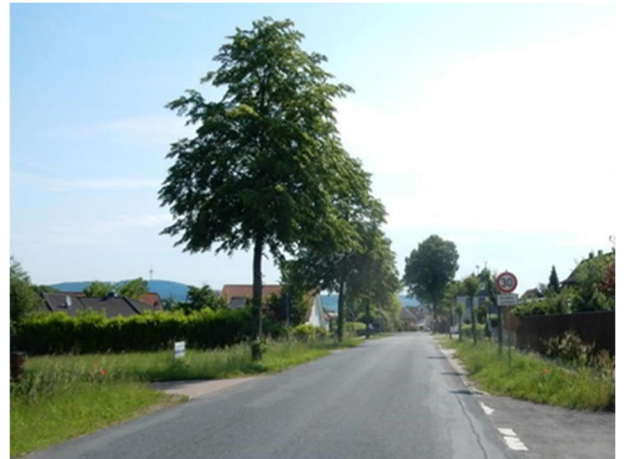
SI: Westfeld - Hauptstraße Tempo 30 wegen Straßenschäden
