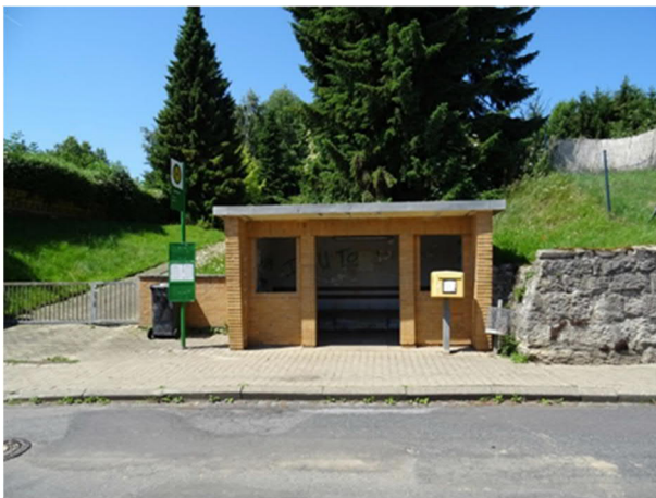
FR: Eyershausen – Hauptstraße Angstrum Wartehäuschen
