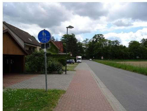
EL: Mehle – Alfelder Straße gemeinsamer Geh-/Radweg
