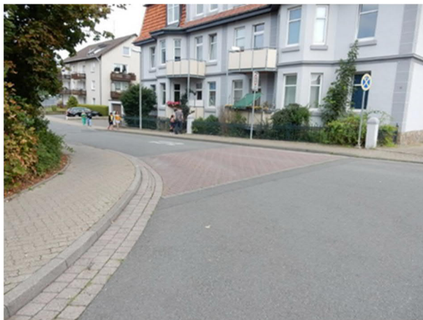
AL: Alfeld – Wiegandstraße Materialwechsel
