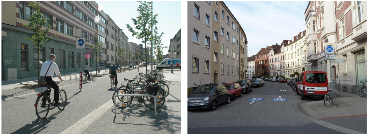
Abb. 55 Beispiele Beschilderung und Fahrbahnmarkierung in einer Fahrradstraße (Hannover)
