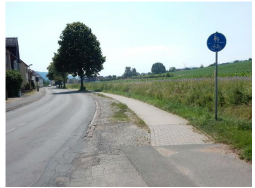
AL: Föhrste – Hann. Südbahn gemeinsamer Geh-/Radweg
