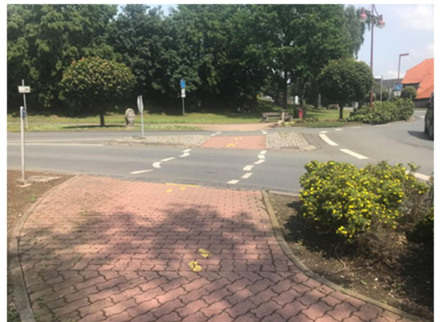
EL: Elze – Wülfinger Straße Querungsstelle an Kreisverkehr
