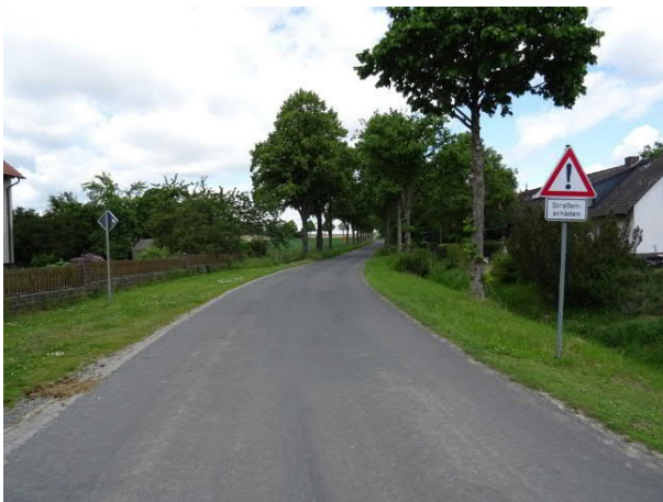
EL: Wittenburg – Sorsumer Straße Beschilderung Straßenschäden
