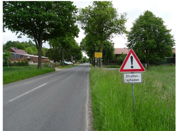
SI: Segeste – Bahnhofsallee (OE) Beschilderung Straßenschäden
